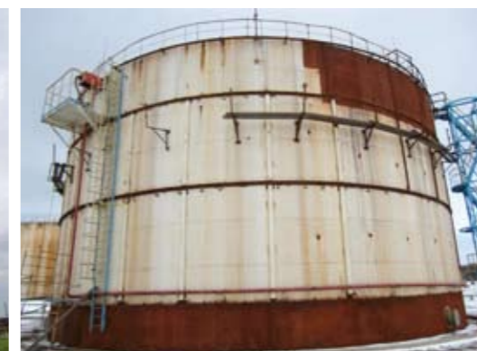
Рис. 10а, рис. 10б. РВС-5000 после комбинированного укрепления стенки
