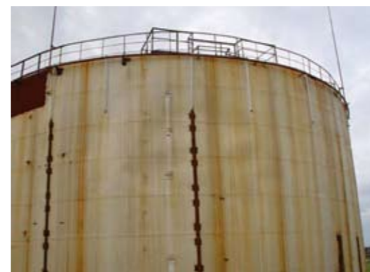
Рис. 9. РВС-5000 до укрепления стенки
