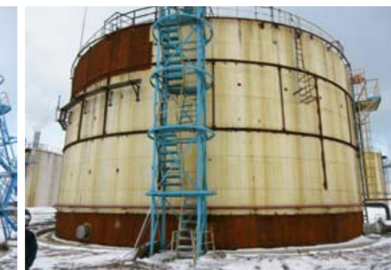
Рис. 10а, рис. 10б. РВС-5000 после комбинированного укрепления стенки
